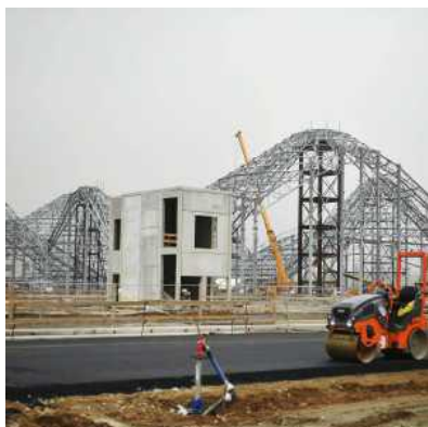
Un cantiere di Expo 2015
